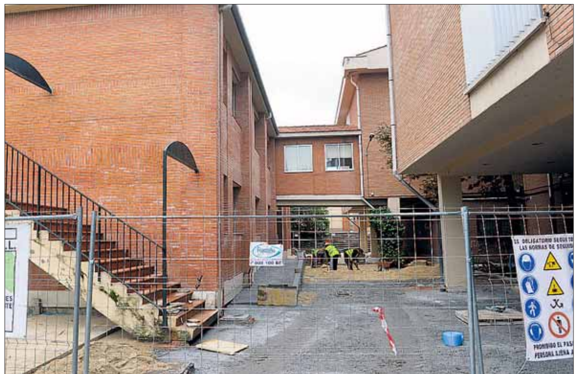
Los obreros eliminan escaleras, colocan rampas, nivelan el terreno e instalan imbornales en los accesos. / KAMARERO
