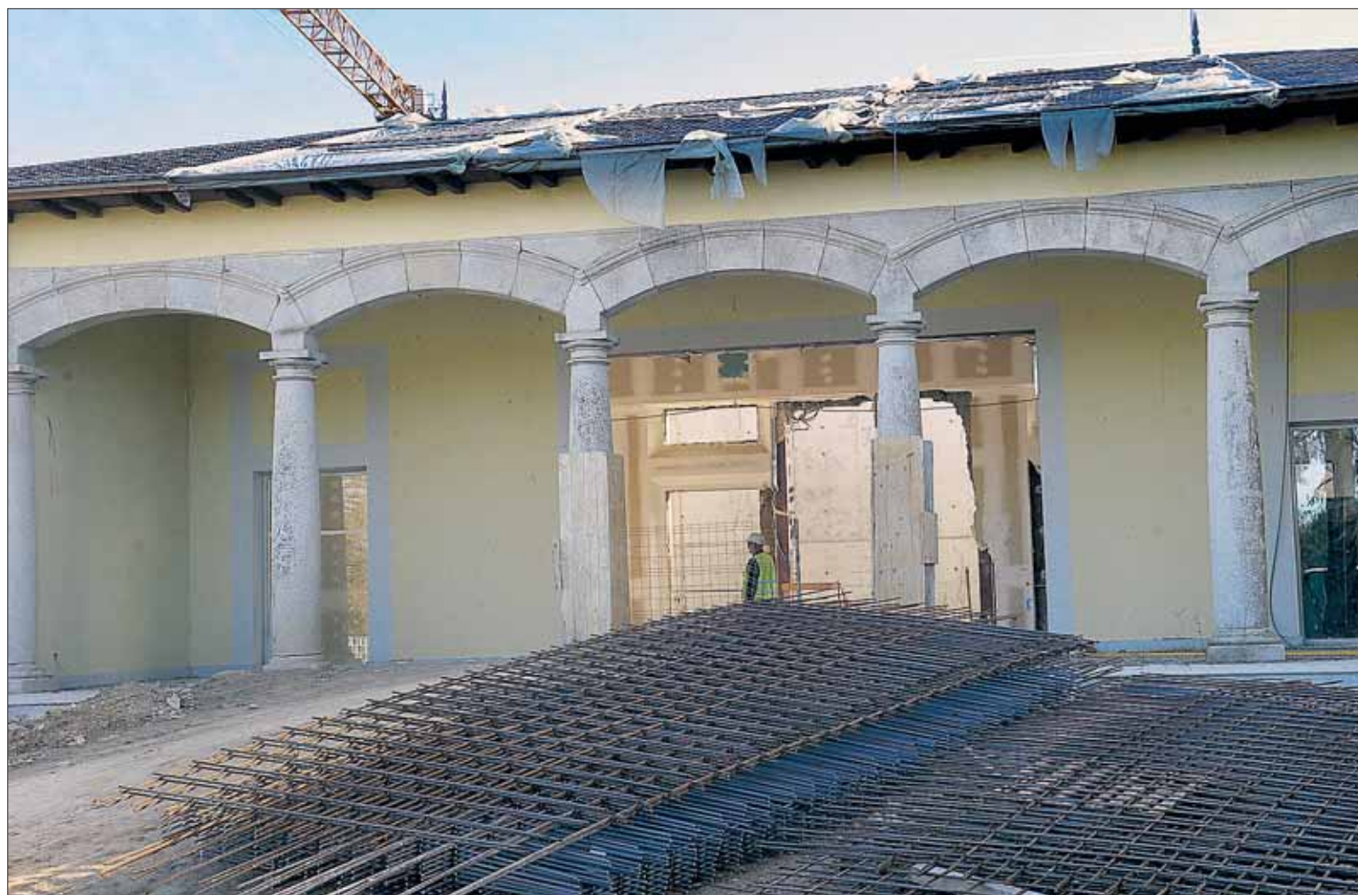
Las obras en la finca de La Faisanera arrancaron el pasado mes de julio y cuentan con un presupuesto de 3,8 millones de euros. / KAMARERO
