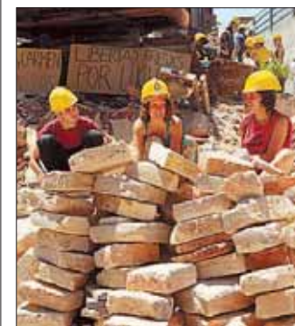
Los vecinos trabajan en la zona.
