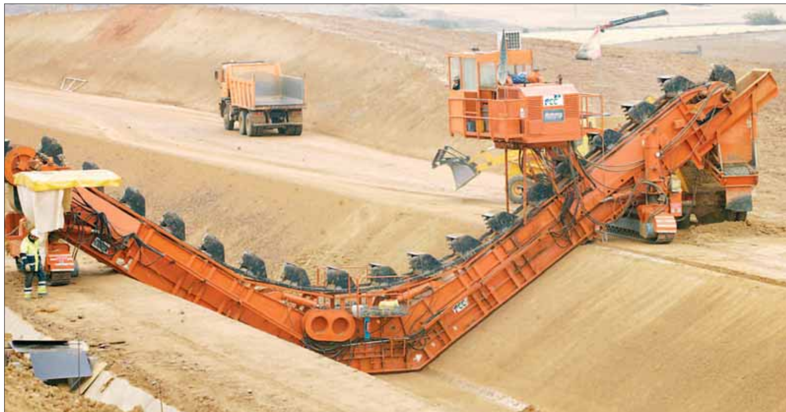
Obras de la segunda fase del Canal Bajo de Los Payuelos, en Castrotierra de Valmadrigal (León), incluidas en el plan de la cuenca del Duero. / C.S.C. (ICAL)
