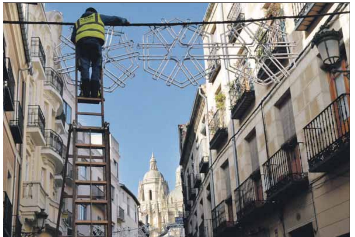
Un operario de la empresa Carmelo Plaza instala un arco luminoso en la Calle Real. / JUAN MARTÍN
