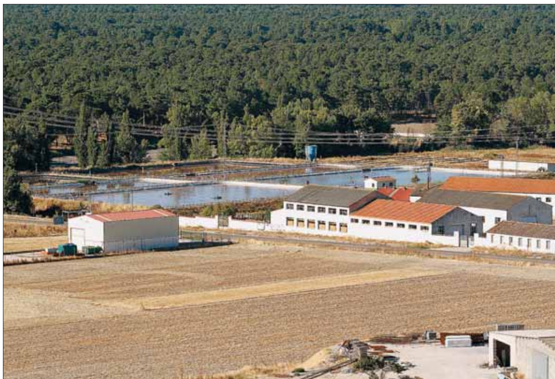
Estación depuradora del municipio, situada en la antigua carretera de Segovia./ GABRIEL GÓMEZ
