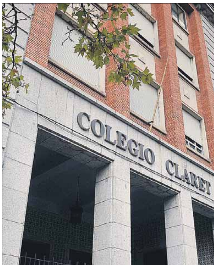
Fachada principal del colegio Claret. / KAMARERO
