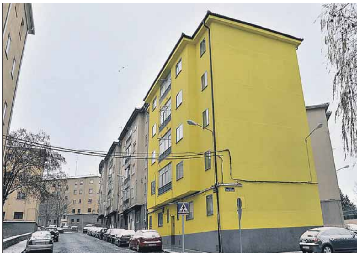
El programa ha permitido rehabilitar fachadas y cubiertas de los edificios de este populoso barrio segoviano. /KAMARERO
