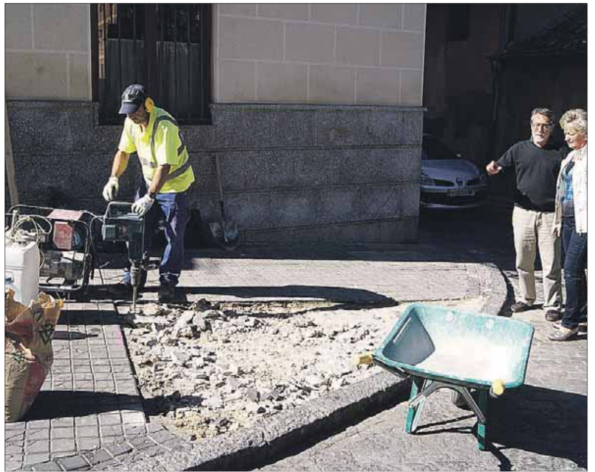
Los operarios de la cuadrilla de obras, durante los trabajos de reparación de una de las calles de San Millán. / EL ADELANTADO
