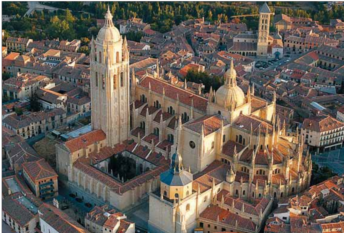
Imagen aérea de la seo segoviana. Las obras permitirán reparar las cubiertas de las naves centrales del templo. / J.MARTÍN
