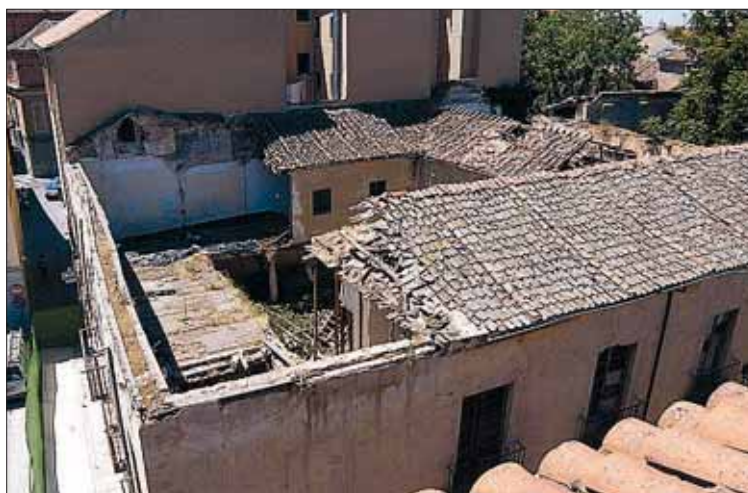
Se implantará un sistema de cubiertas para proteger los muros. / JUAN MARTÍN
