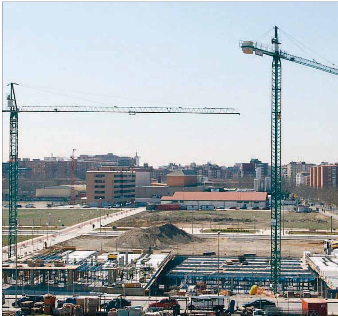
Construcción de viviendas VPO en Valladolid. / RUBÉN CACHO (ICAL)
