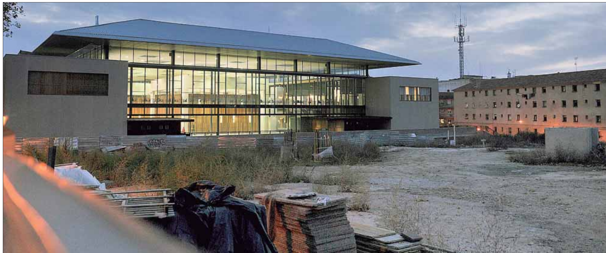
El solar con escombros, restos de obra y maleza evidencia que han pasado más de 600 días desde que se pararon las obras del campus María Zambrano del que solo se ha construido la mitad. / KAMARERO
