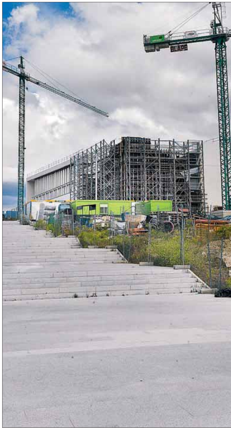
La actividad de máquinas y operarios cesó ayer en las obras del CAT. / KAMARERO
