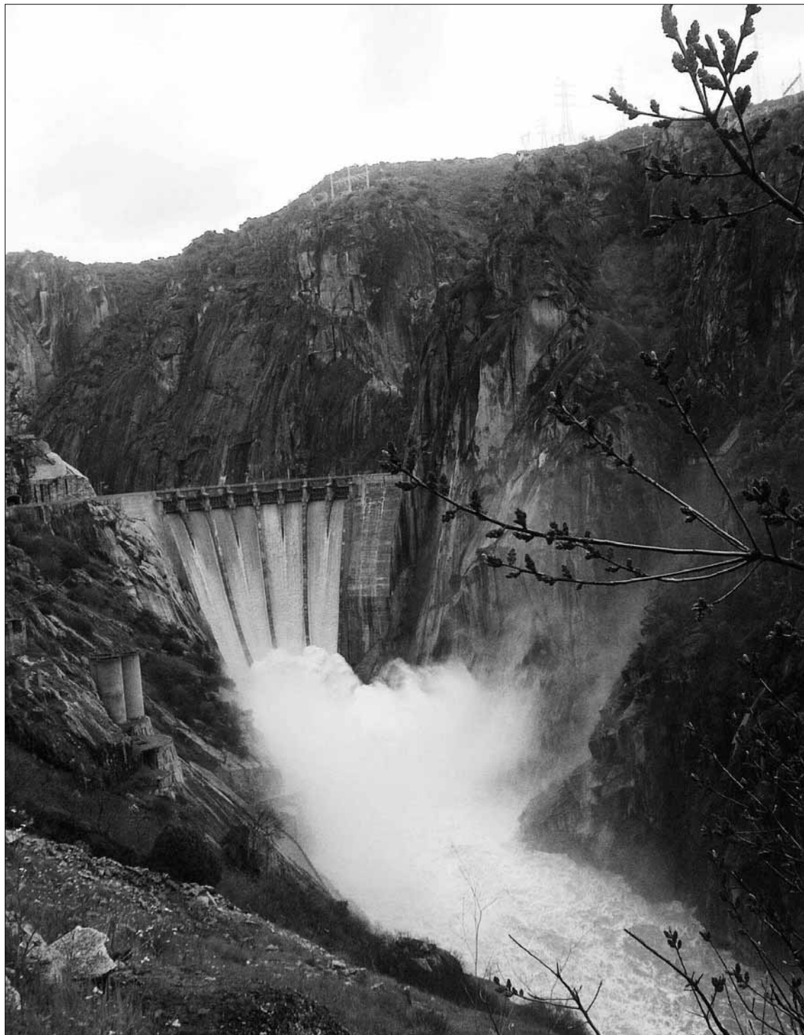
Imagen de la presa de Aldeadávila de la Ribera (Salamanca), un salto de agua sobre el río Duero. / ICAL
