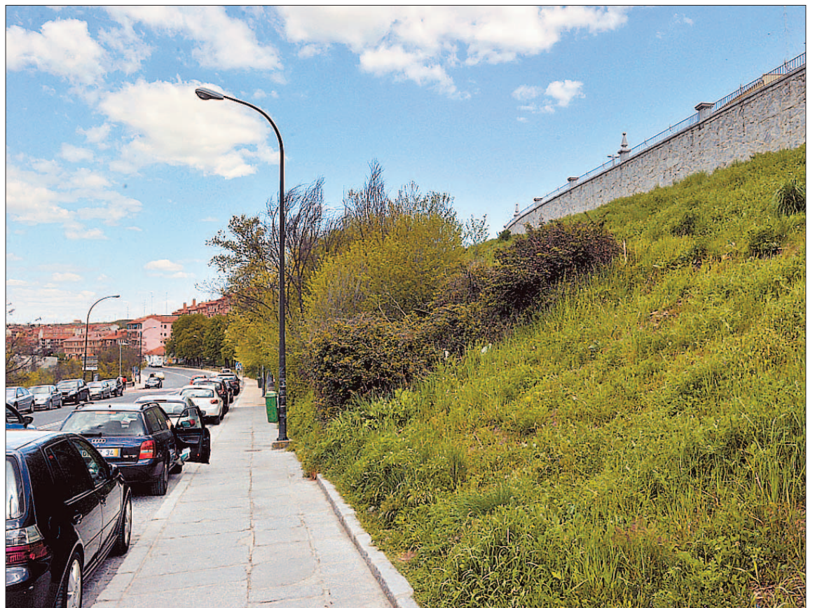
El talud de la avenida de Padre Claret, en una fotografía reciente. / KAMARERO
