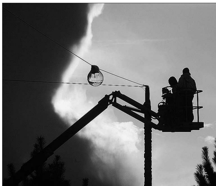
Unos empleados arreglan un problema en un tendido eléctrico. / ÁNGEL AYALA
