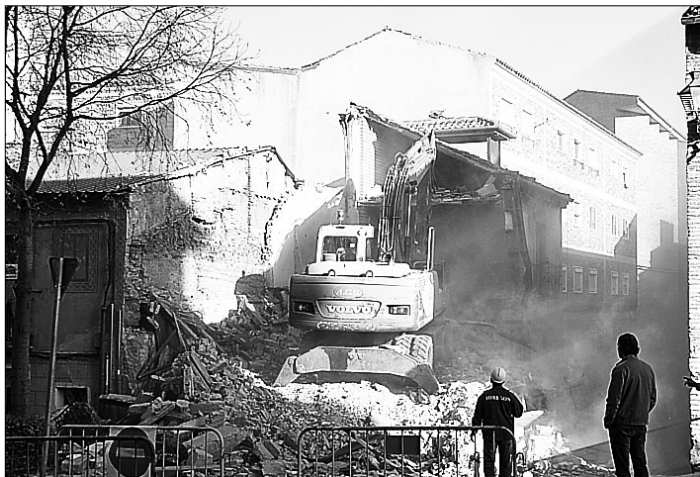
Una máquina excavadora, ayer, durante las tareas de demolición. / J. MARTÍN
