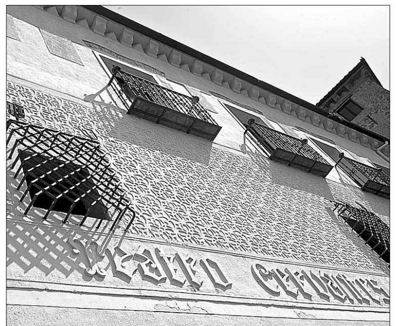
Fomento ha renunciado a la adjudicación del contrato de obras. / KAMARERO
