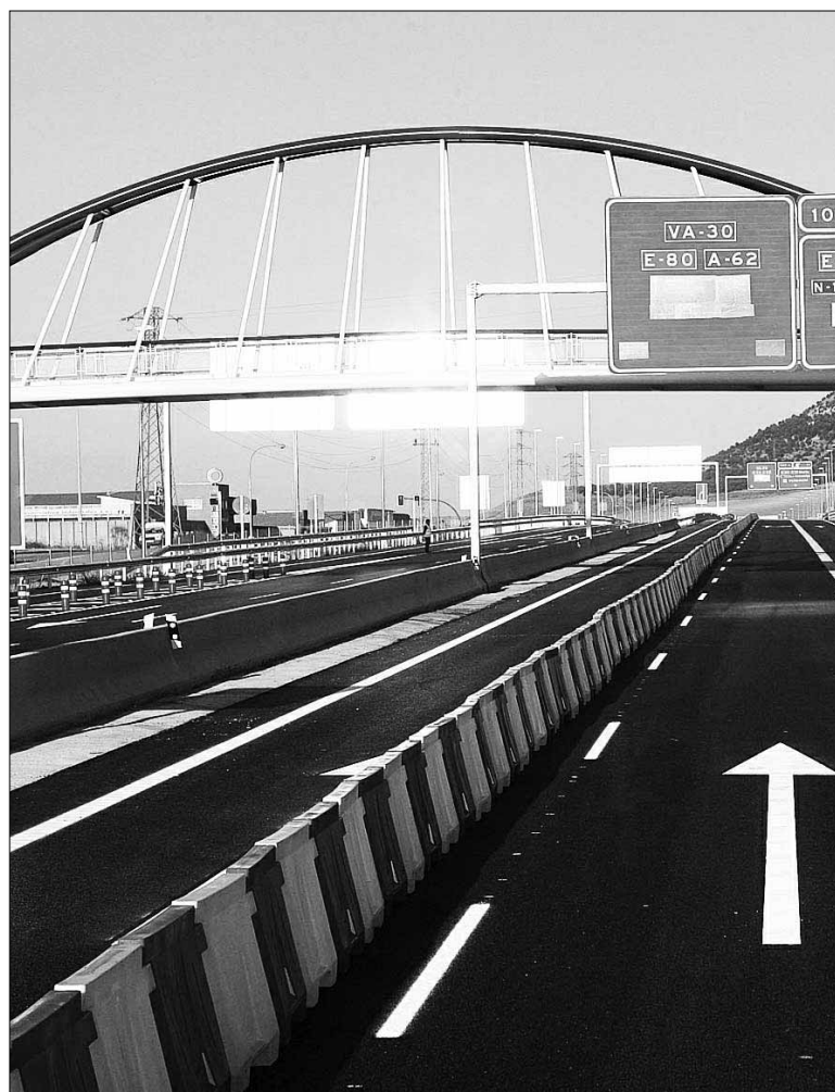
Avanzan a buen ritmo las obras de la Ronda Exterior Este de Valladolid. / ICAL
