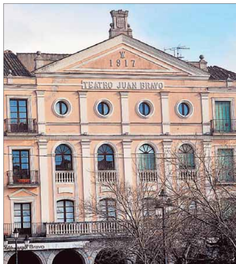
Fachada del teatro Juan Bravo, propiedad de la Diputación Provincial. /KAMARERO
