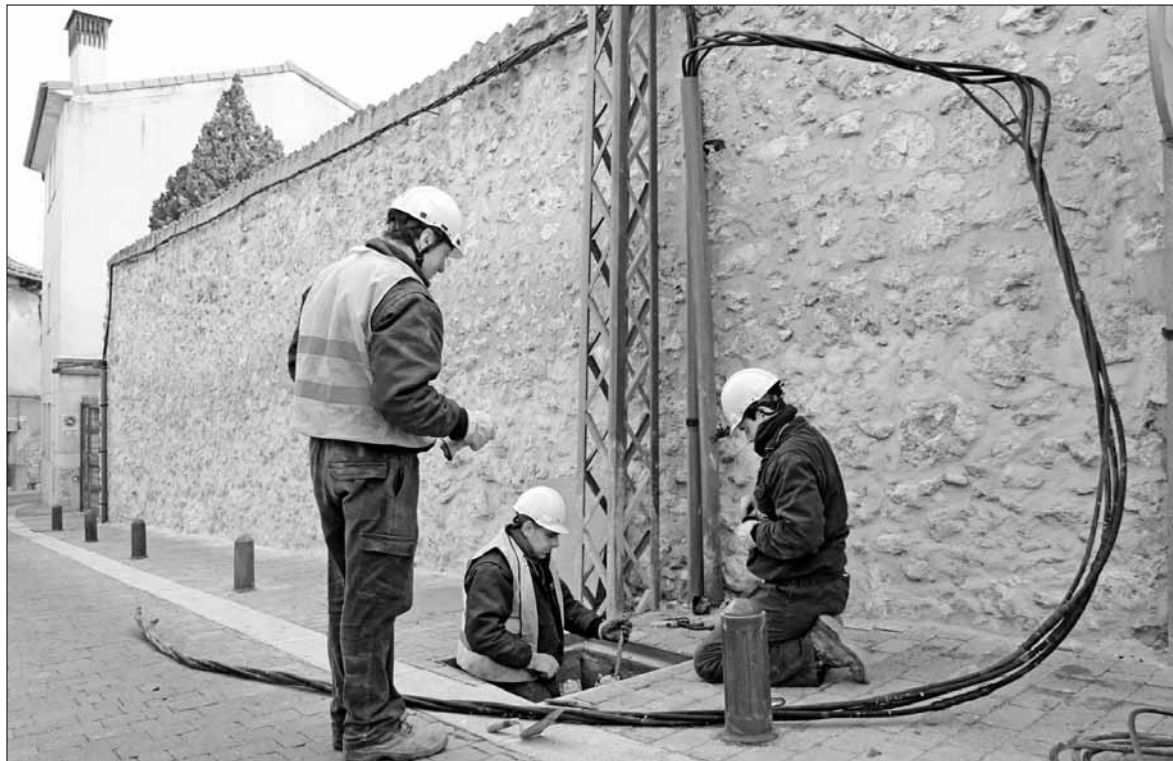
Trabajadores, durante las tareas de soterrado del cableado en la calle San Julián. / GABRIEL GÓMEZ
