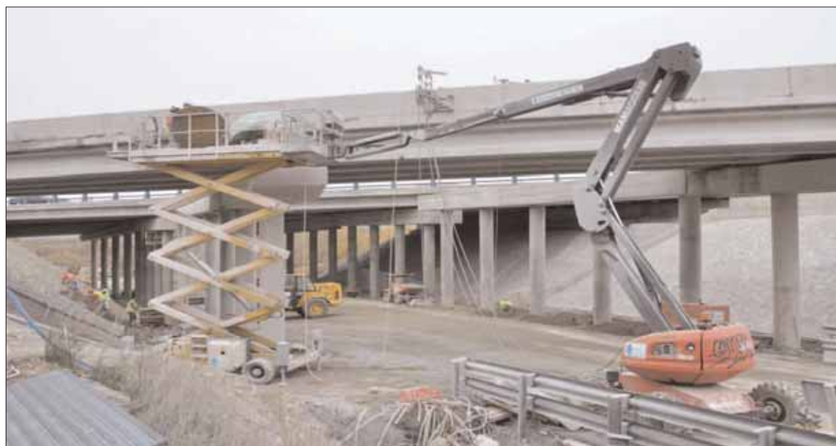
Obras de sustitución de uno de los viaductos que se han llevado a cabo en la autopista. / PEDRO L. MERINO
