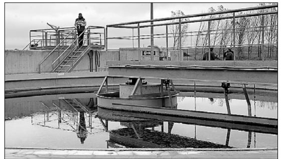
Imagen de una estación depuradora situada en la provincia. / KAMARERO
