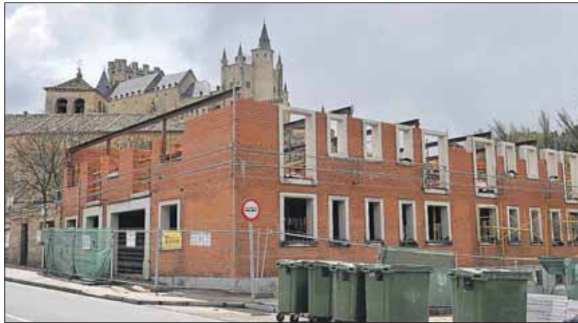
El edificio que se construye en la calle de San Marcos número 25 está amparado por el Plan Especial aprobado en 1999. J.A.K.
