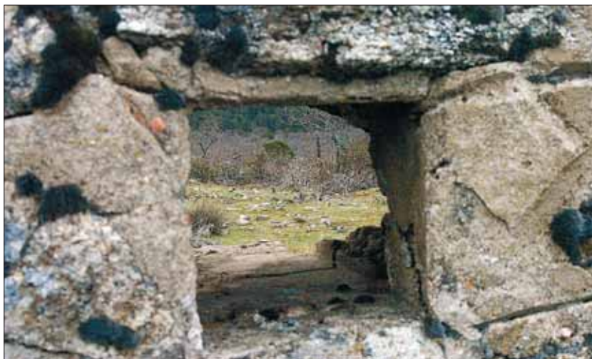
Puesto de tiro para el disparo con Mauser, tal y como se halla en la actualidad. / GUILLERMO HERRERO
