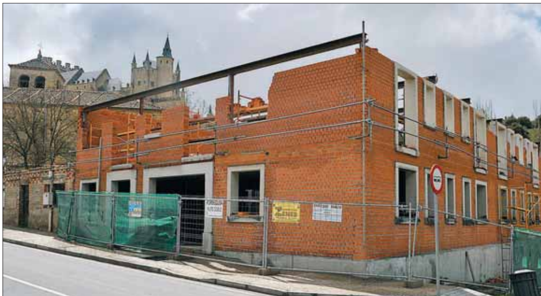
Edificio en construcción que generó la apertura de diligencias, a la altura del número 25 de la calle de San Marcos, en el barrio del mismo nombre. / KAMARERO
