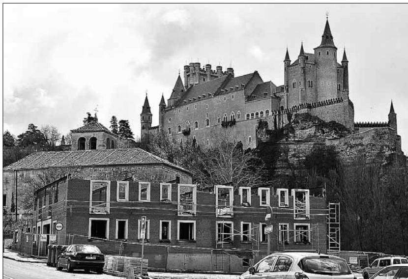
Imagen del edificio en construcción ubicado en el solar del número 25 de la calle de San Marcos. / KAMARERO
