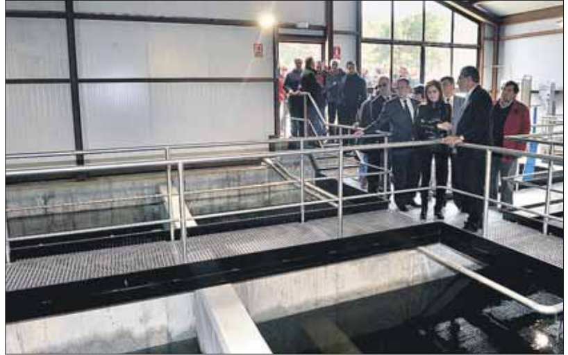
Los alcaldes y las autoridades visitaron las instalaciones de la nueva Estación Depuradora situada junto a la presa. / KAMARERO
