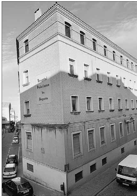
Edificio del Hospital Policlínico, en la calle San Agustín. / KAMARERO
