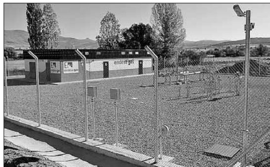
Instalaciones de la planta de gas en El Espinar. / PEDRO L. MERINO
