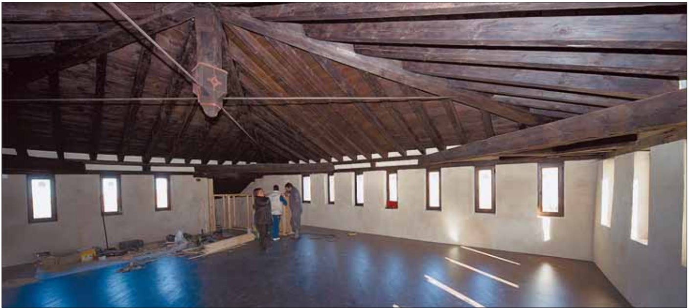
Planta alta de la Puerta de Santiago. La cubierta es una armadura, de doble cuadrado, de pendolón, del siglo XVIII, que ha sido restaurada, sustituyendo algunas de las piezas de madera. / KAMARERO
