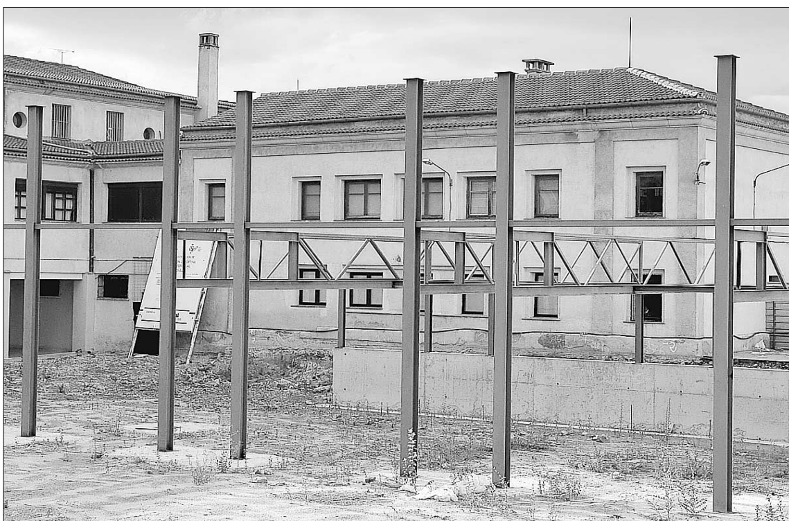
Estructura metálica instalada al inicio de las obras del pabellón deportivo del CEIP El Peñascal. / ALBERTO BENAVENTE
