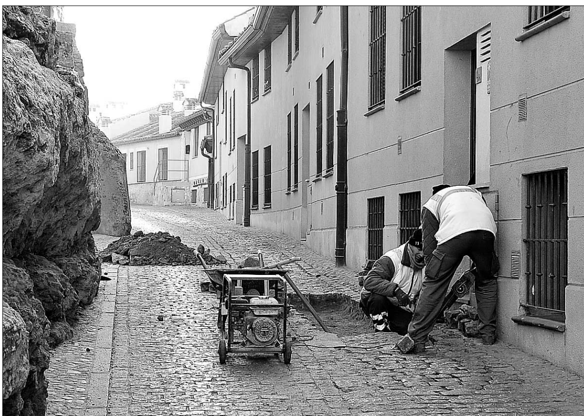
Las obras comenzaron ayer en Leopoldo Moreno. La calle permanecerá cerrada al tráfico hasta el próximo viernes. / A.B.
