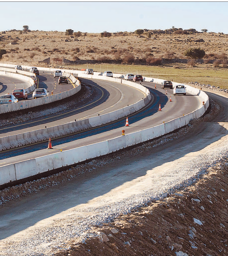
Trabajos auxiliares para no interrumpir la circulación en ningún momento. / PEDRO L. MERINO
