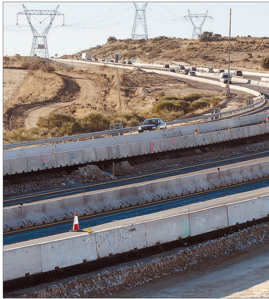
Las obras de construcción del tercer carril entre San Rafael y Villacastín han obligado a realizar t
