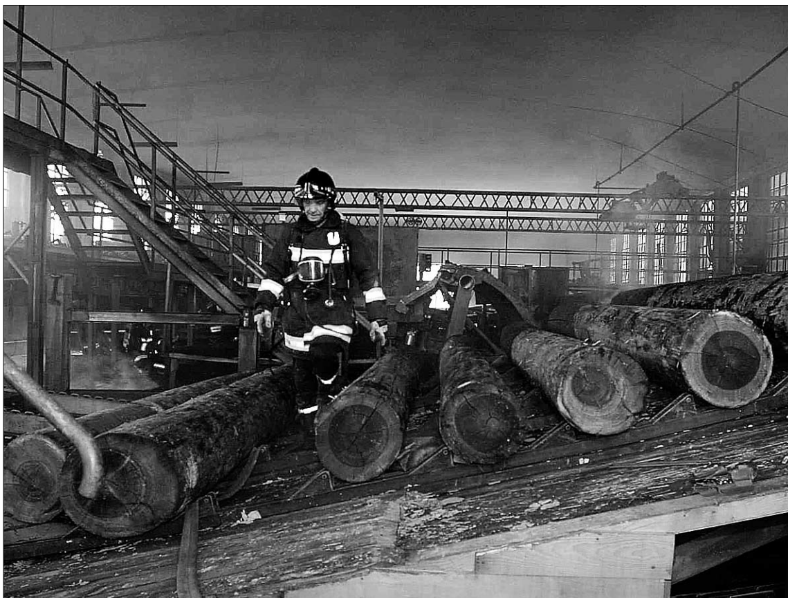
Imagen de un bombero tras sofocar el incendio que se declaró en el inmueble en octubre de 2005./F. PEÑALOSA
