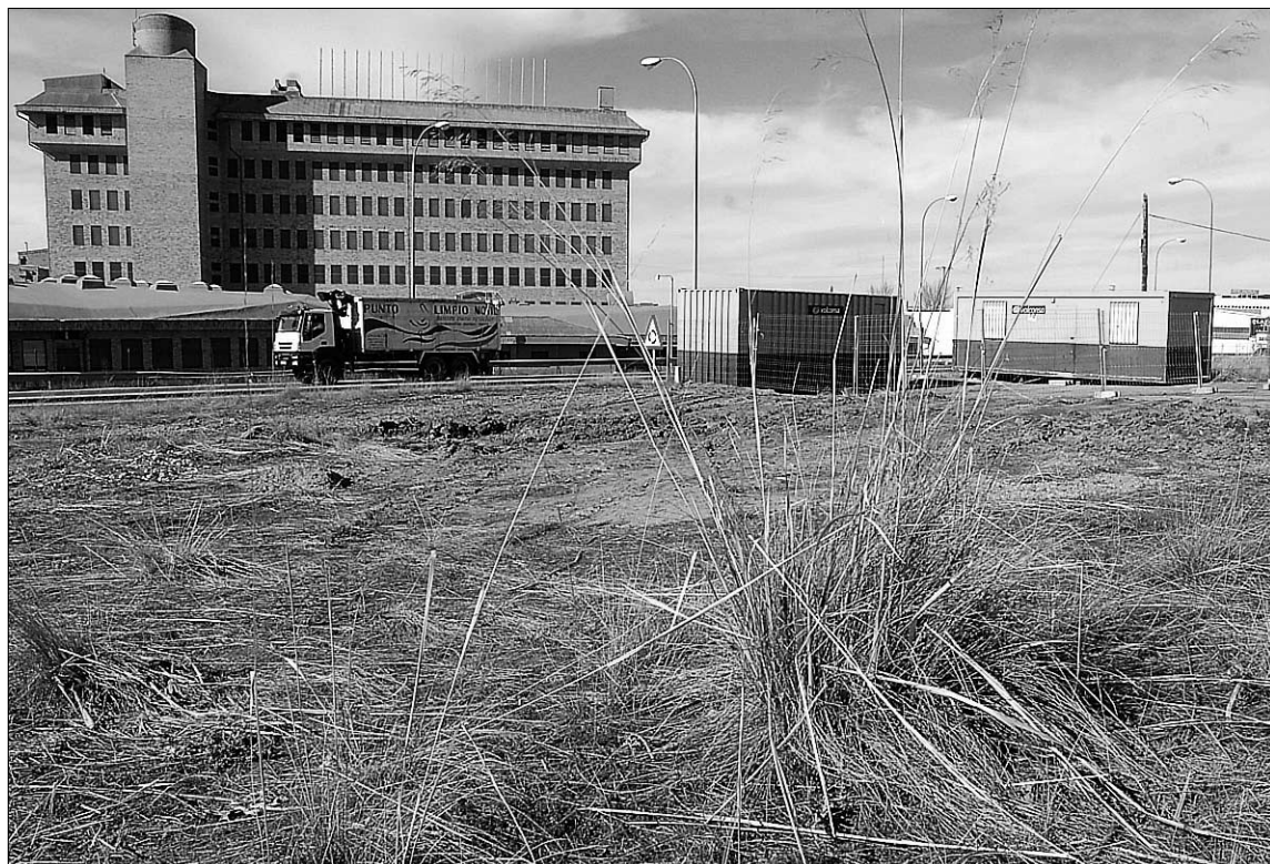
Volconsa ha instalado ya las casetas para el acopio de materiales de las obras./ALBERTO BENAVENTE
