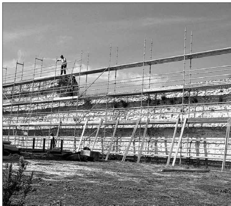
Andamios instalados en la muralla junto al Castillo. / GABRIEL GÓMEZ
