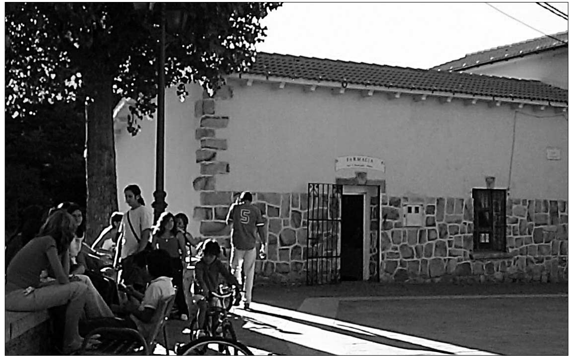
Al fondo la actual farmacia, inmueble donde se intervendrá y se realizará una nueva planta superior. / ÁLVARO PINELA
