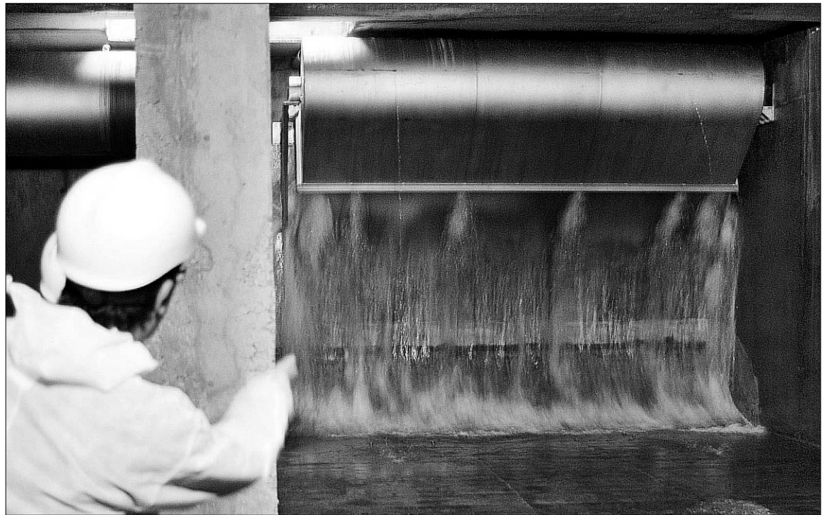
Interior de la cámara de tormentas del colector de San Marcos que ayer visitó el alcalde de la ciudad. /KAMARERO
