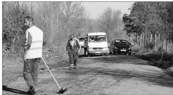
Obreros trabajando en la carretera. /FERNANDO PEÑALOSA
