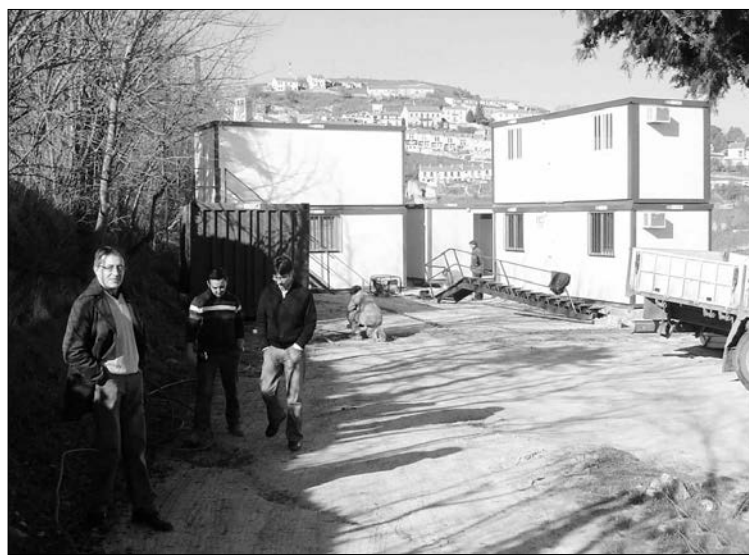
Superficie en la que se realizarán las obras. /EL ADELANTADO
