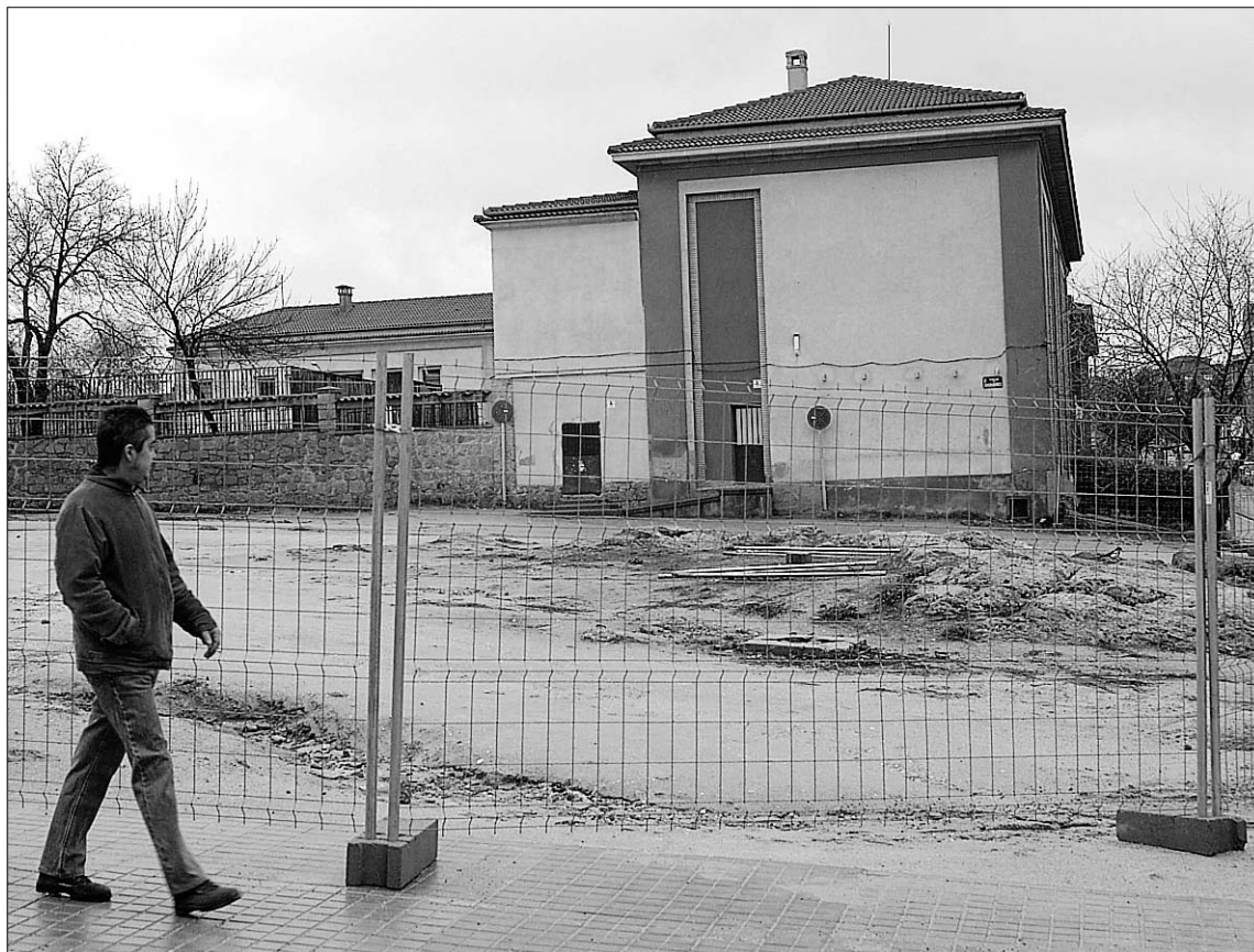
La colocación de la valla delimitando la parcela donde se creará el nuevo edificio anuncia el inicio de las obras./JUAN MARTÍN
