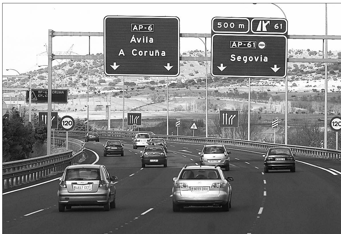
Tramo de la autopista AP-6 (Villalba-Adanero), en término municipal de El Espinar/JUAN MARTÍN
