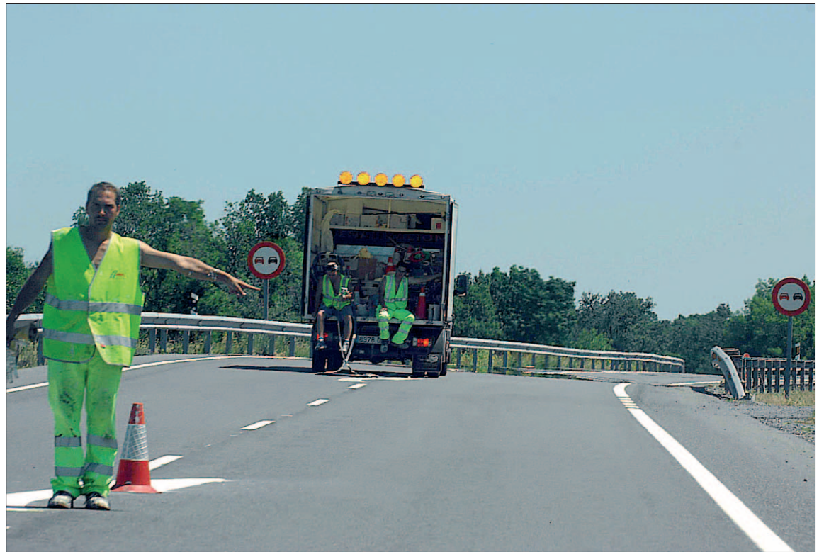
Trabajos de mejora de la señalización de la vía, a su paso por la provincia segoviana, realizados en julio de 2007. / JUAN MARTÍN
