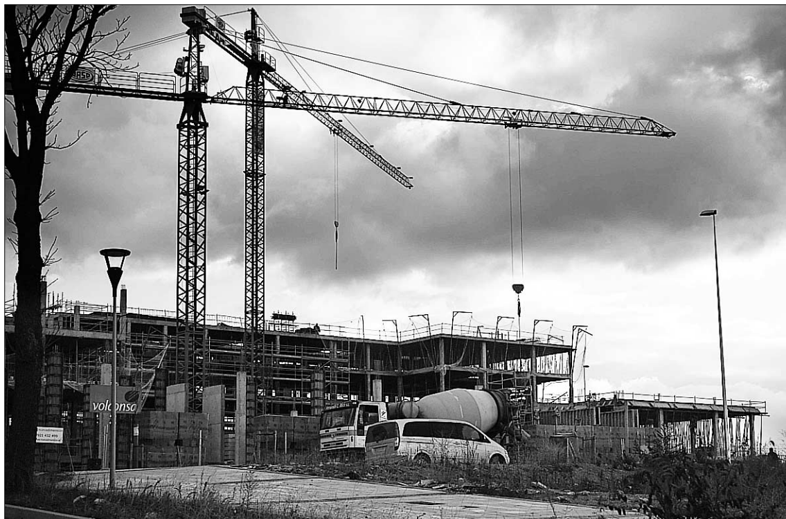
Viviendas en construcción en la capital Segoviana, que mantiene precios medios muy altos. / KAMARERO
