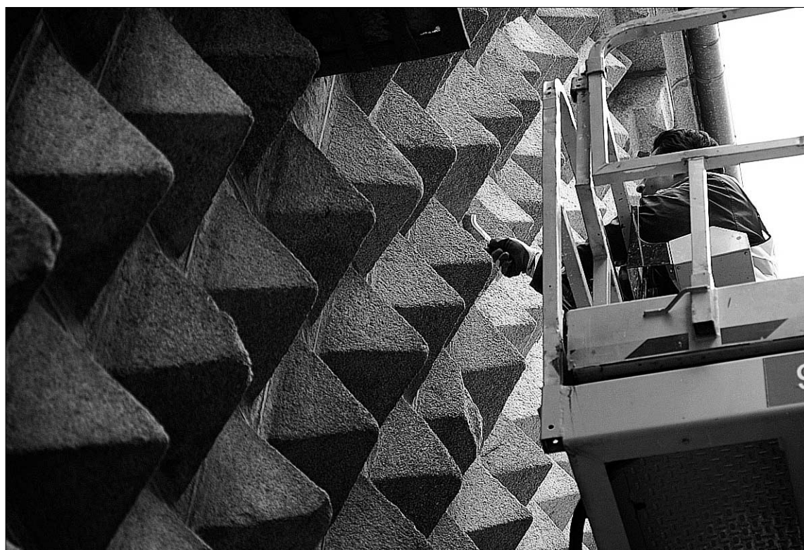
La empresa Geocisa ha vuelto a intervenir en los prismas para evitar la descomposición del granito. / KAMARERO
