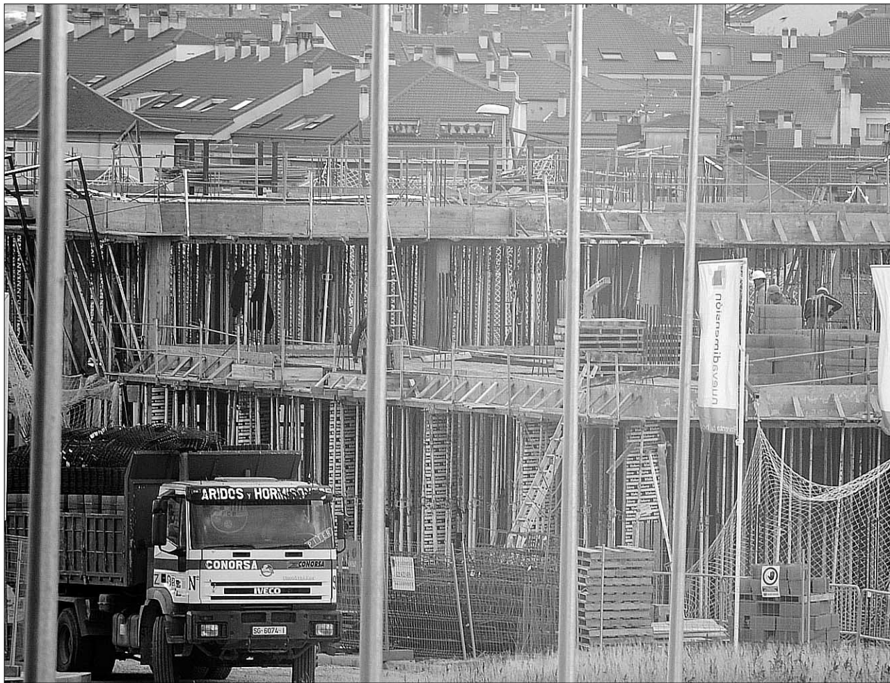
Viviendas en construcción en el sector Plaza de Toros de la capital segoviana, cuyo desarrollo urbanístico se ha visto frenado por la actual
