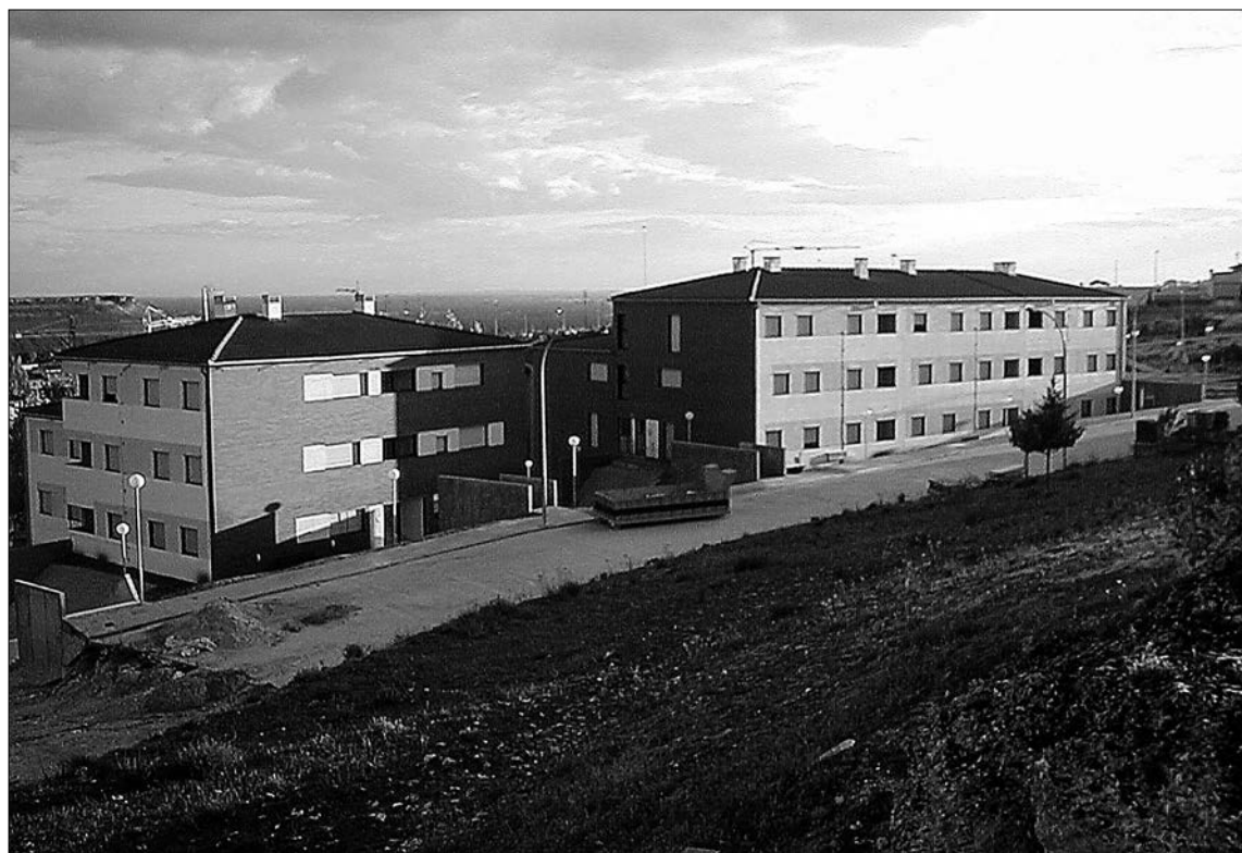
Entorno en el que se construirán las viviendas junto a la anterior promoción entregada en 2001. / GABRIEL GÓMEZ
