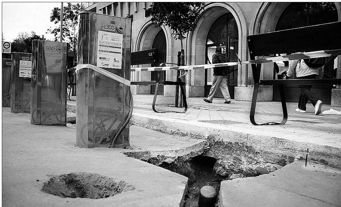
El Ayuntamiento ha comenzado las tareas para la cimentación de la futura "marquesina solar" para las bicicletas/KAMARERO.
