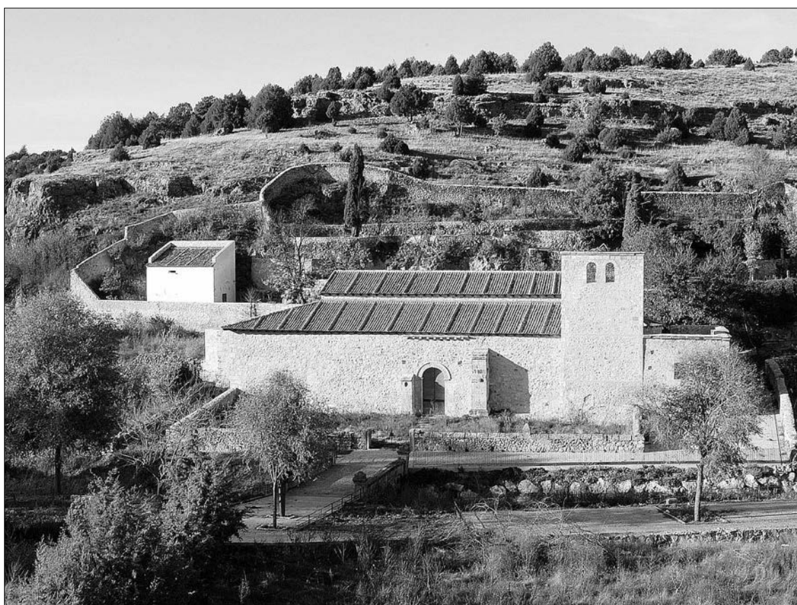
Imagen de la iglesia románica de San Miguel una vez terminada su restauración. / GUILLERMO HERRERO.
