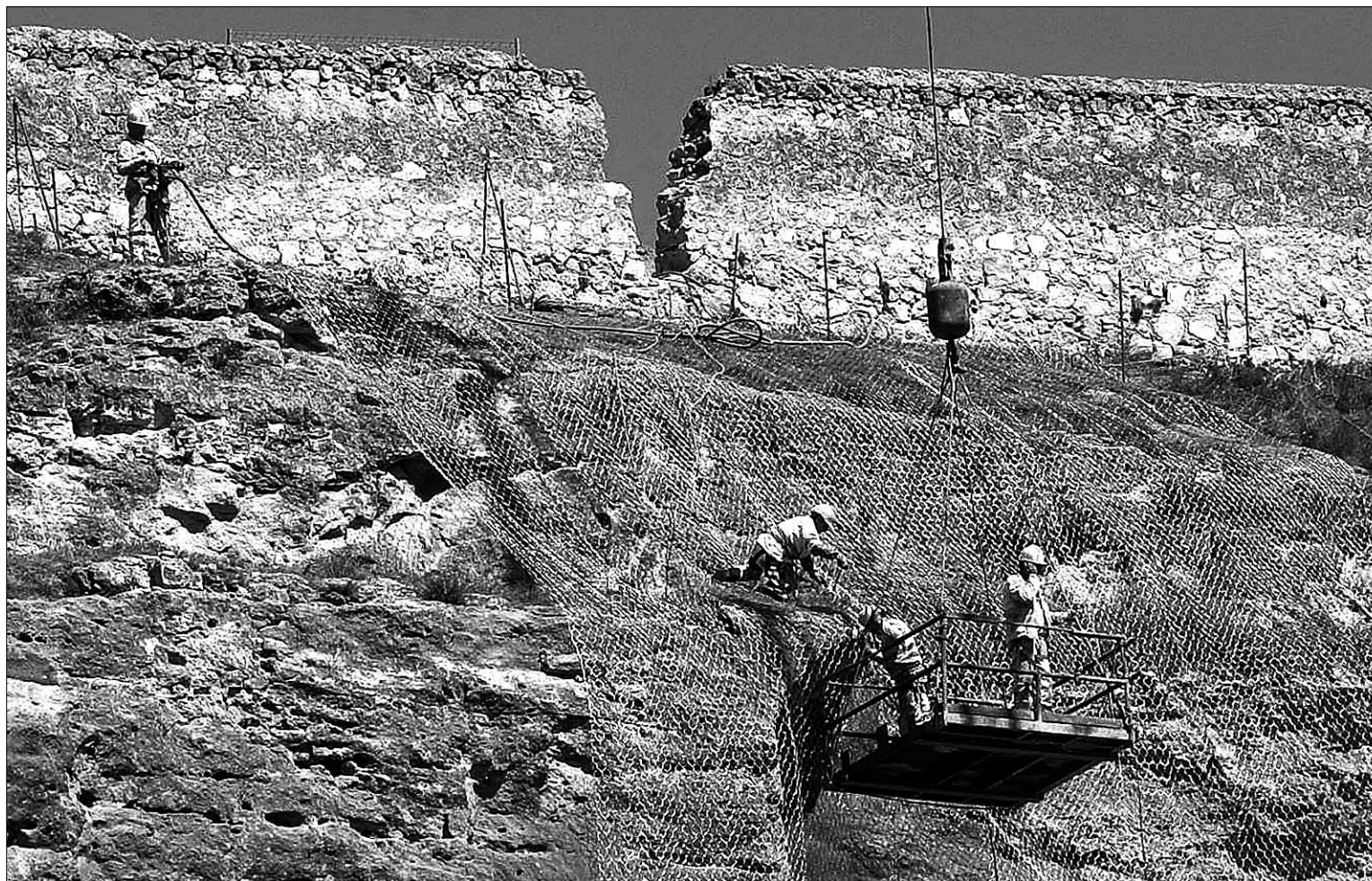
Los trabajos de consolidación del roquedo fueron realizados con carácter de urgencia y sufragados íntegramente por la Junta de Castilla y León. // JUAN MARTÍN
