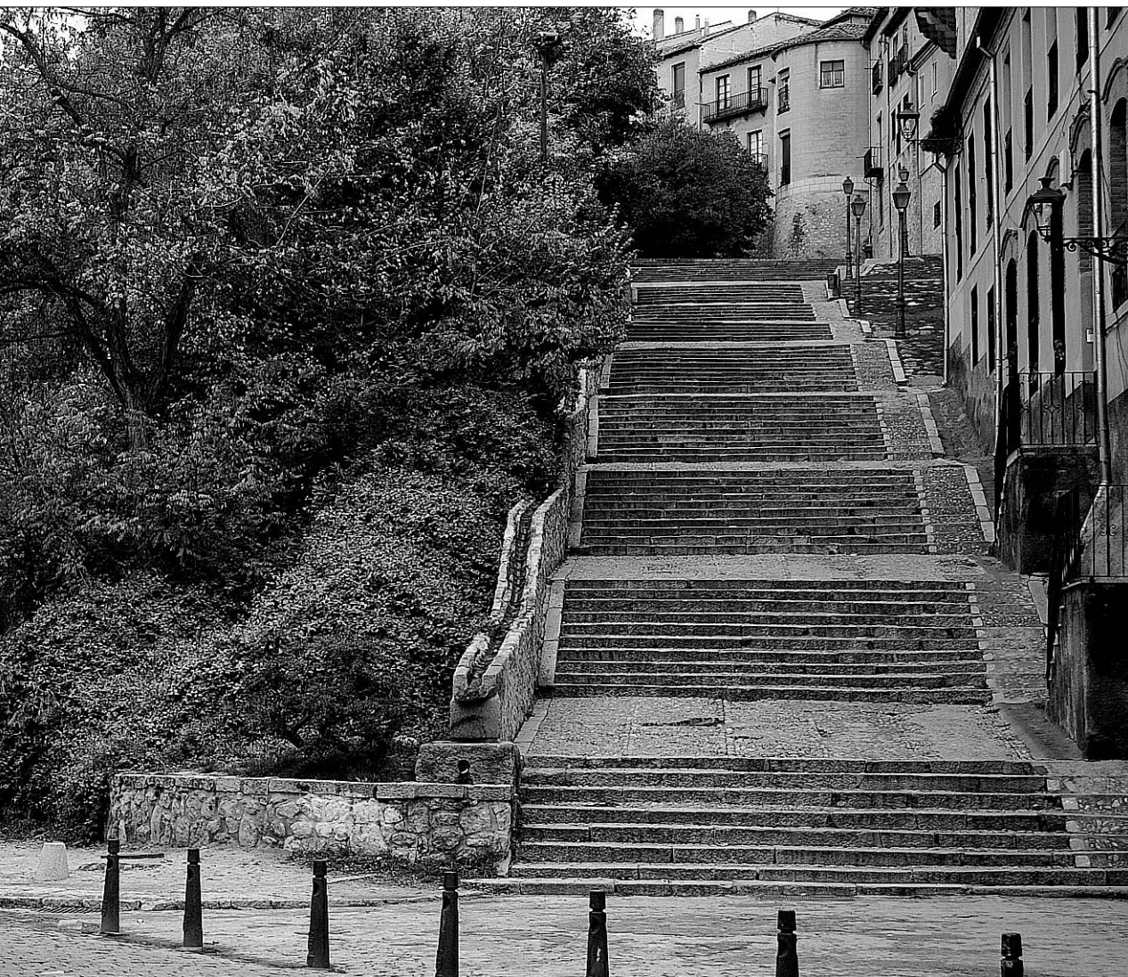
El muro de mampostería entre el Paseo de los Tilos hasta la mitad de la calle de San Millán/KAMARERO
