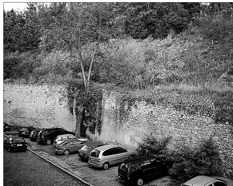
En esta zona se abrirá la puerta de acceso a las escaleras y ascensor soterrados/KAMARERO
