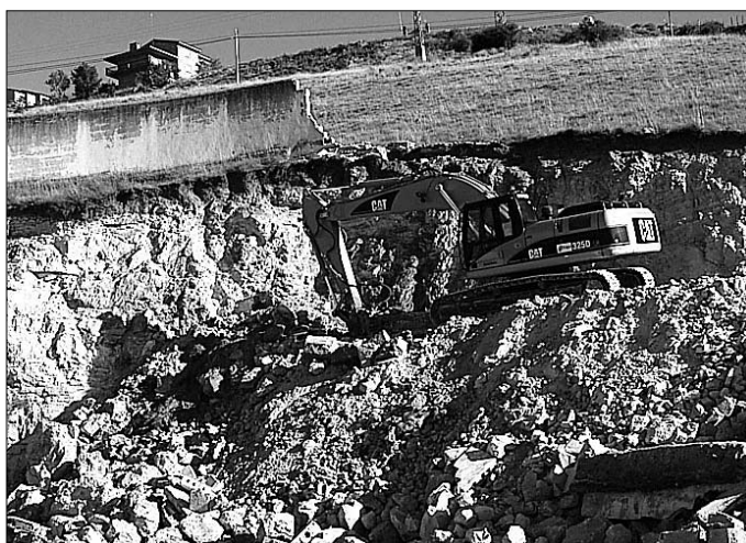
Obras de ampliación de la Plaza de Toros. / EL ADELANTADO
