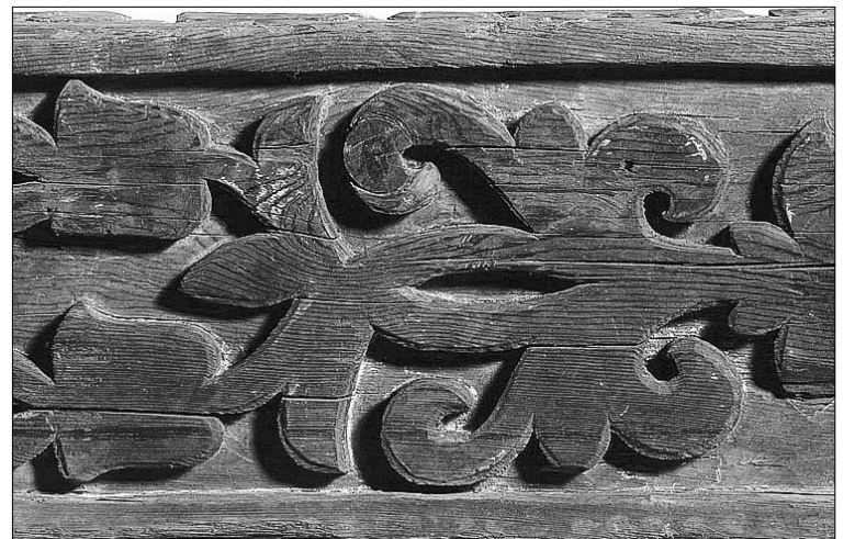
Detalle de una de las cinco vigas procedentes de la Mezquita de Córdoba.
