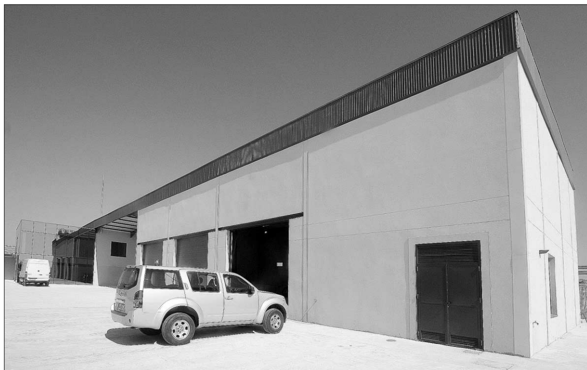
El centro de conservación y explotación se sitúa en la salida norte de Carbonero el Mayor. /FERNANDO PEÑALOSA
