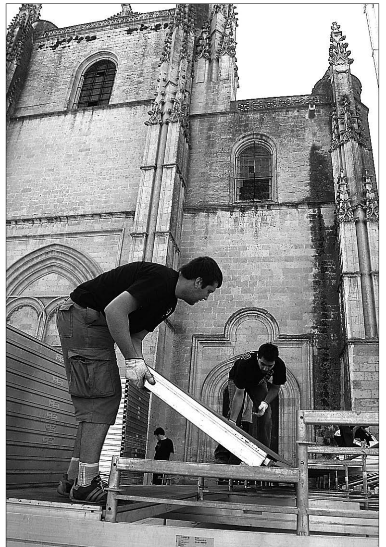
El graderío instalado tiene capacidad para 800 localidades/PEÑALOSA
