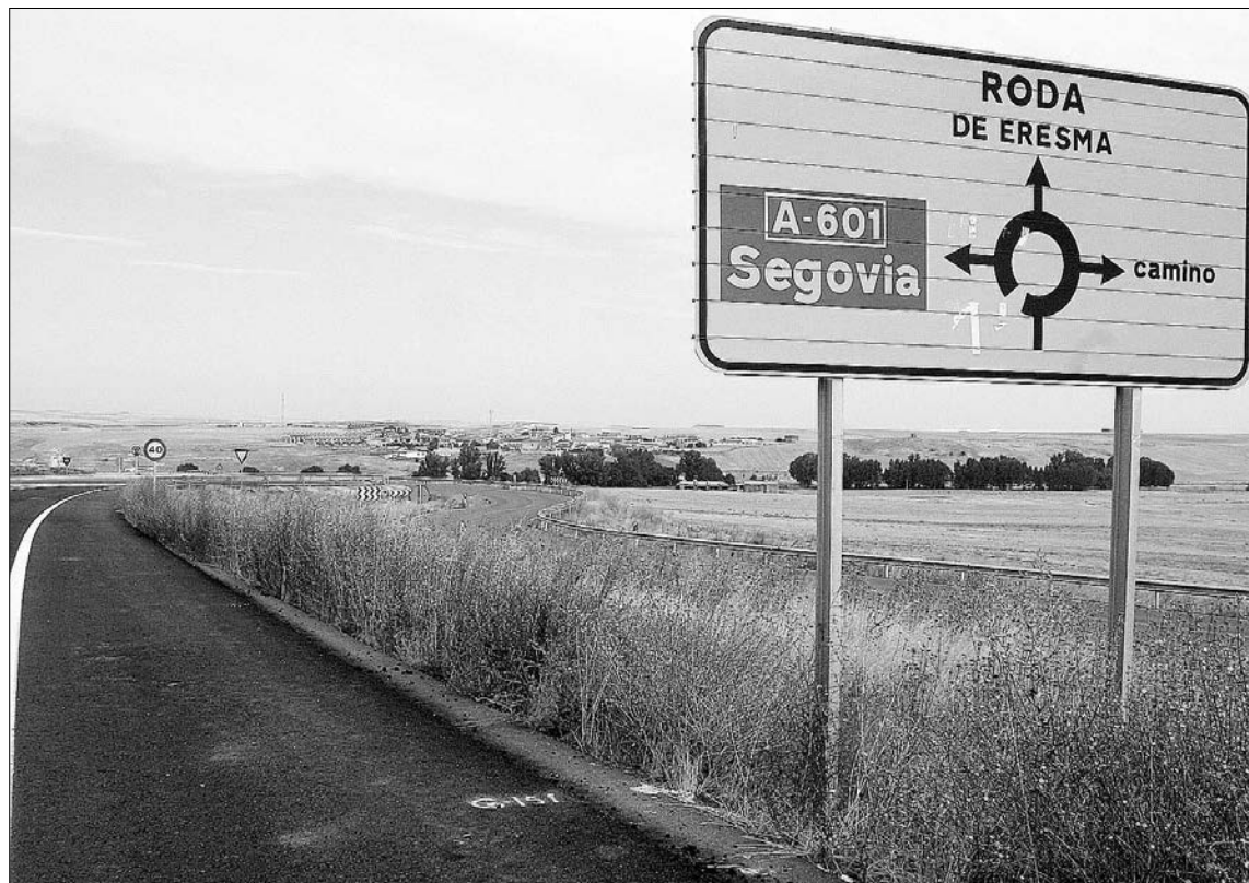
Vista del carril de acceso sur a Roda de Eresma desde la autopista Segovia-Valladolid, aún en construcción. / F. PEÑALOSA
