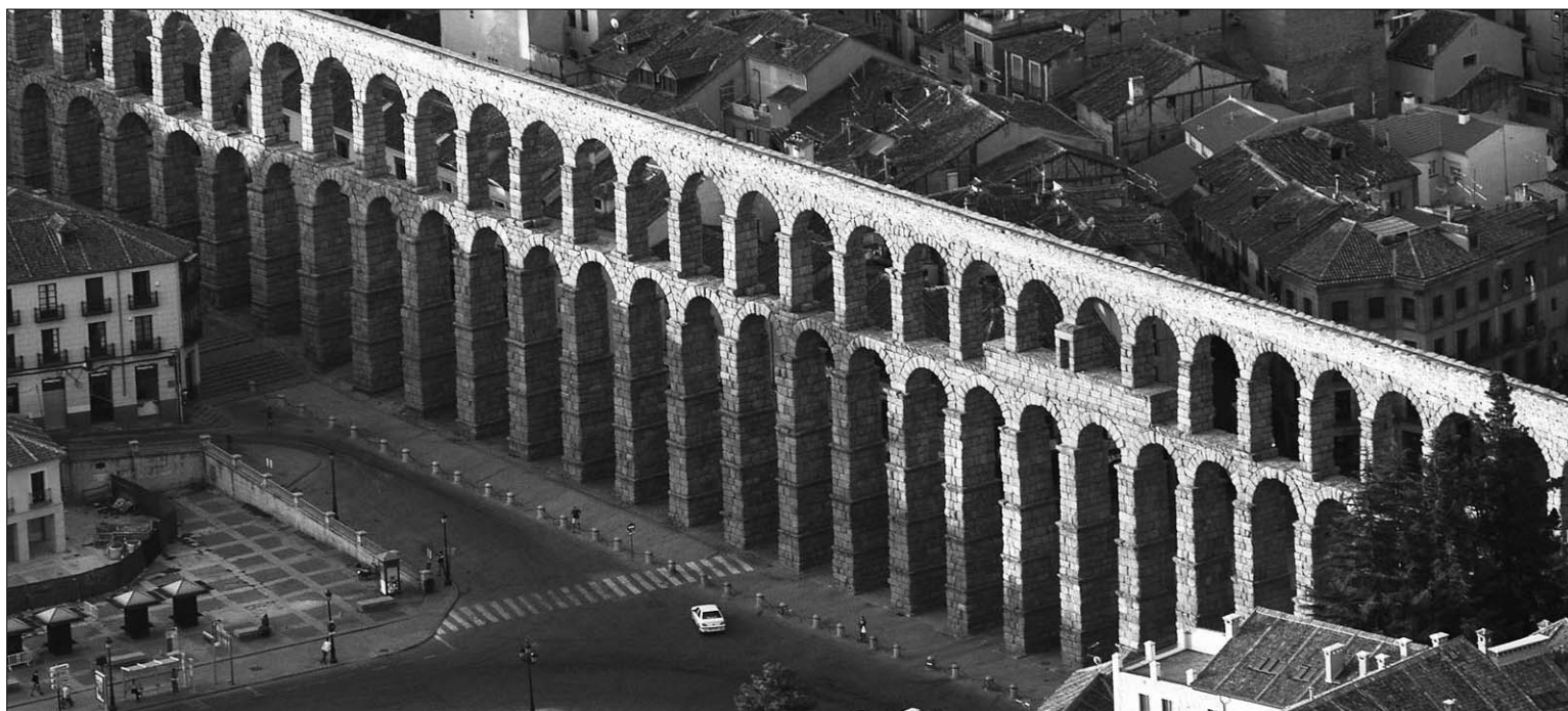
La última restauración del Acueducto se prolongó de 1992 a 2000, y en las obras se invirtieron alrededor de siete millones de euros/JUAN MARTÍN
