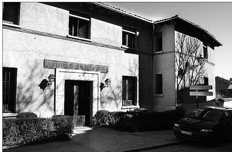
Fachada principal del Hospital de la Misericordia/BEATRIZ VELASCO
