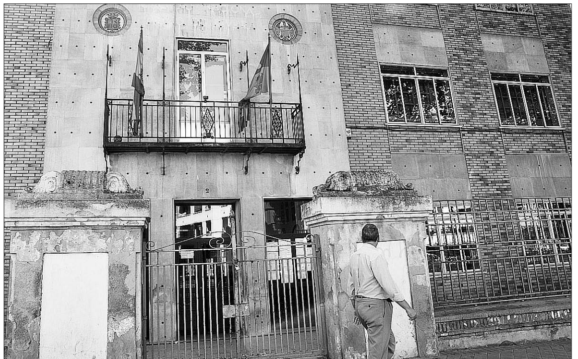
Imagen correspondiente a la fachada del CEIP 'Diego de Colmenares' de Segovia. / KAMARERO
