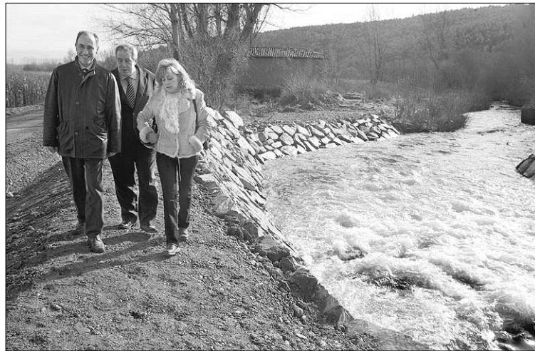
Gato (i) durante una visita a las obras en el cauce del río Eria, en Zamora. / ICAL
