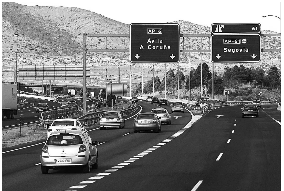
La zona de los túneles de Guadarrama y las cabinas de peaje se prevé entre las más conflictivas. / JUAN MARTÍN
