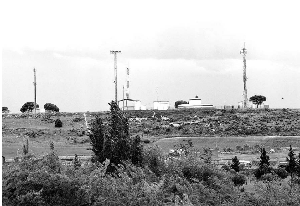
La torre del reemisor instalada en Las Lomas será sustituida en octubre por otra de mayor altura. / GABRIEL GÓMEZ
