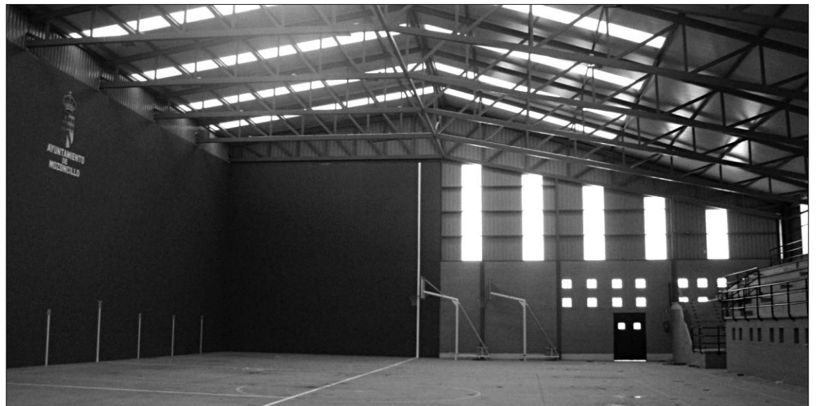
Las obras del nuevo pabellón deportivo multiusos, erigido sobre el antiguo frontón, están a punto de finalizar. / EL ADELANTADO
