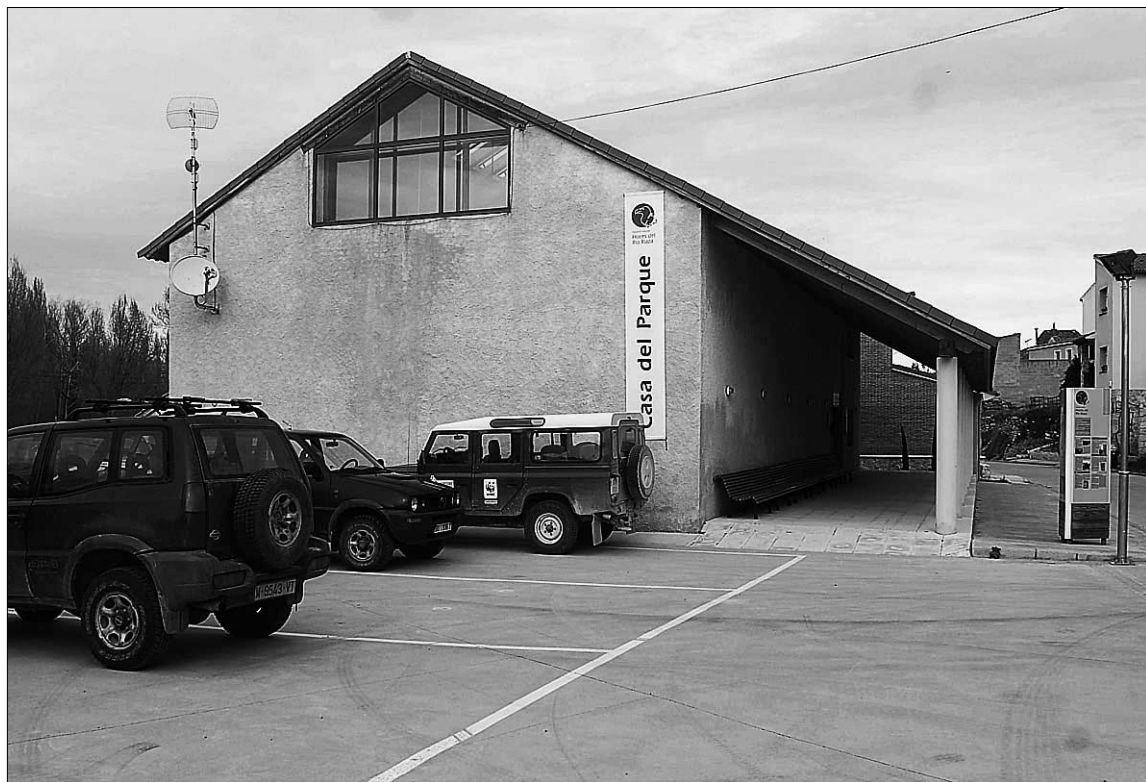
Casa del Parque de las Hoces del Riaza, que será ampliada en los próximos meses. / KAMARERO
