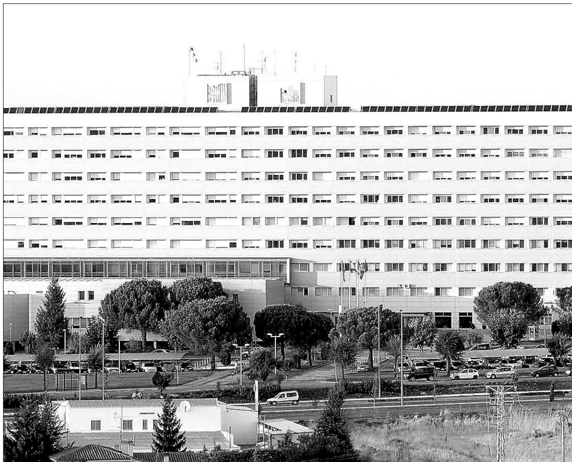
Hospital Nuestra Señora de Sonsoles de Ávila con placas de energía solar en la azotea. / M. MARTÍN (ICAL)
